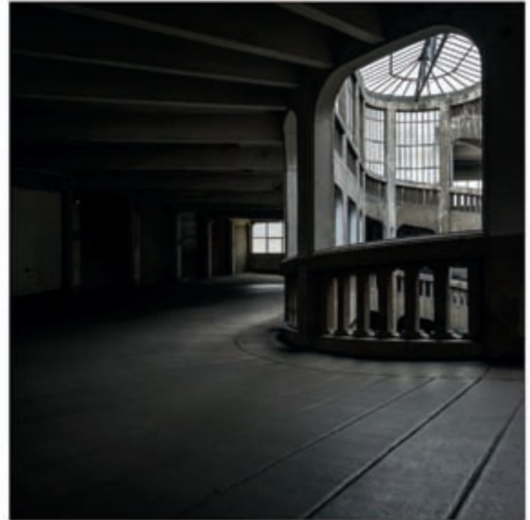
La construction en béton armé est assise sur une base elliptique dont la partie centrale est un vaste puits autour duquel s'élève une rampe desservant 252 garages implantés sur quinze demi niveaux. L'originalité de l'édifice est d'être particulièrement discret. Quasi invisible depuis la rue, rien ne permet de supposer la présence d'un tel ouvrage à cet endroit, si ce n'est sa porte d'entrée.
